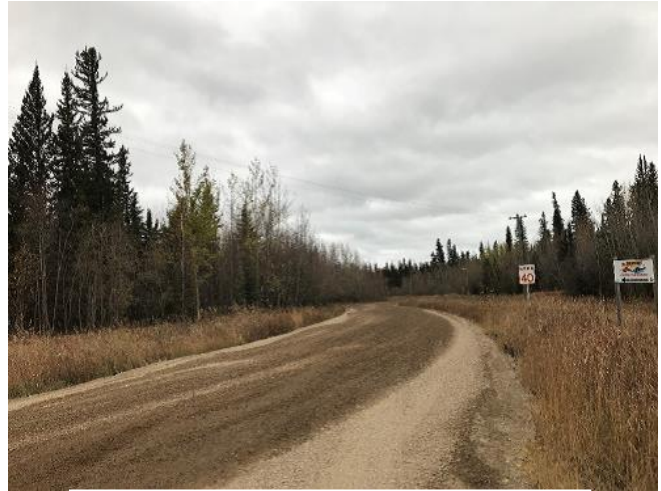
Route d'accès à la plage de Hay River
