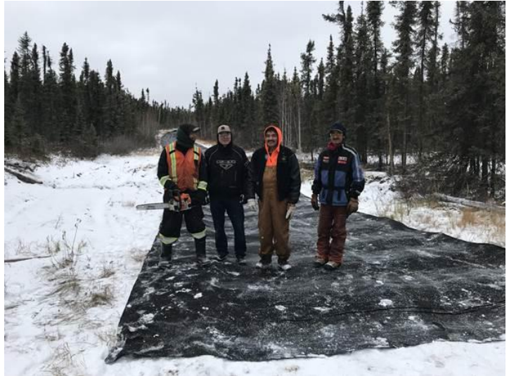
Travailleurs œuvrant à la construction de la route d'accès
