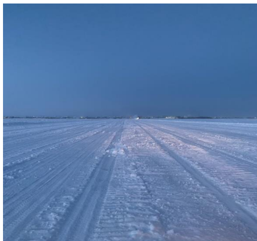
Vue de la voie de raccordement menant à la route de glace de Behchokò – hiver 2021-2022.
