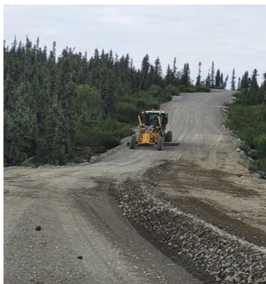
Nivellement de la route d'accès de Wekweètì durant les travaux qui ont eu lieu à l'été 2021.
