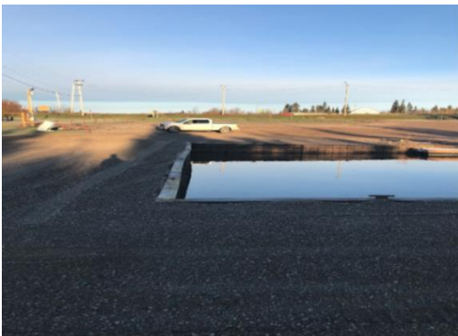
Mur de soutènement de la rive sud de la marina de Porritt Landing après les travaux de l'été 2021
