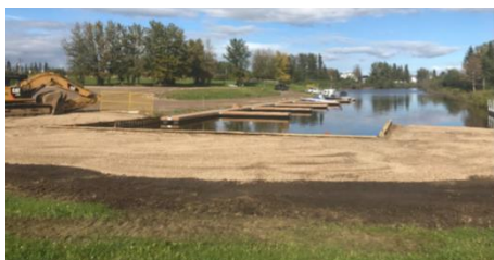
Rive sud de la marina de Porritt Landing du port de Hay River après les travaux de l'été 2021.
