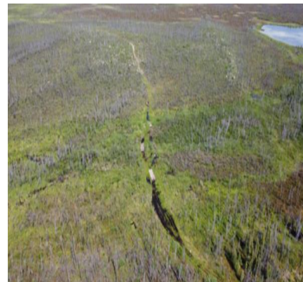
Vue aérienne des ponts construits sur le sentier d'accès communautaire à Secondary Beach de 3,6 km pour VTT, motoneige et marche de Whati.
