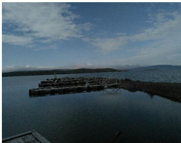
Installations nautiques de Łutselk'e après la rénovation des trois quais et du brise-lames.
