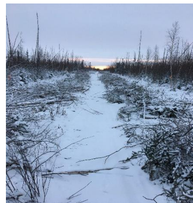
Construction en cours le long du nouveau sentier de quad et de promenade du ruisseau Four Mile à Tulita.
