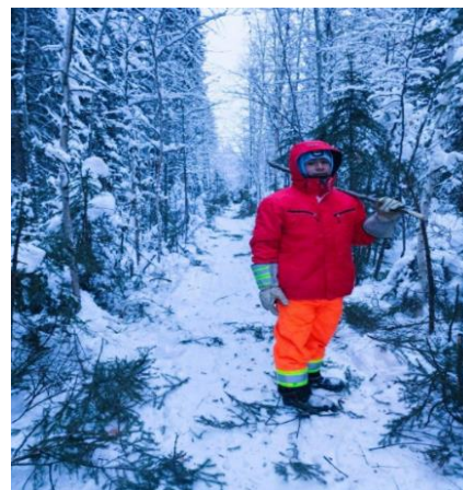
Poursuite des travaux de construction des sentiers d'accès à Nahanni Butte en hiver 2022-2023
