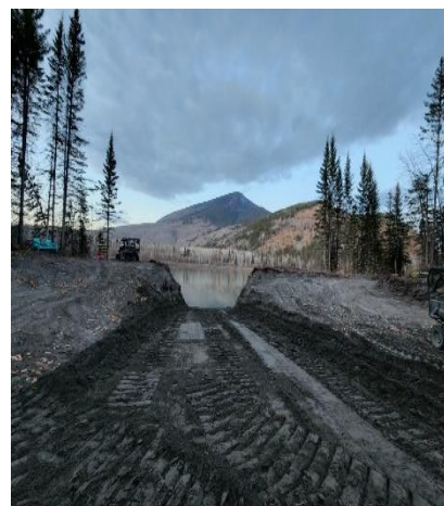
La nouvelle rampe de mise à l'eau de Nahanni Butte après l'achèvement de la phase II des travaux de construction.
