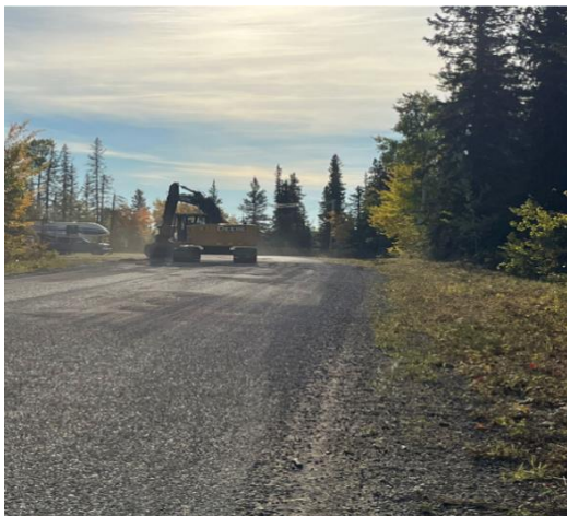
La poursuite des travaux de construction de la route d'accès du chemin Hoffman est en cours dans la Ville de Hay River.
