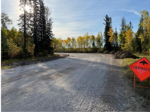
Section courbe en cours de construction sur la route d'accès du chemin Hoffman à Hay River.
