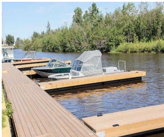
Vue de la marina de Porritt Landing après les travaux de construction, à Hay River.
