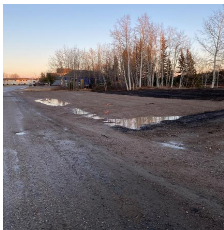
Vue de la nouvelle aire de stationnement de la rampe de mise à l'eau du parc Bob McMeekin après l'achèvement des travaux de construction.
