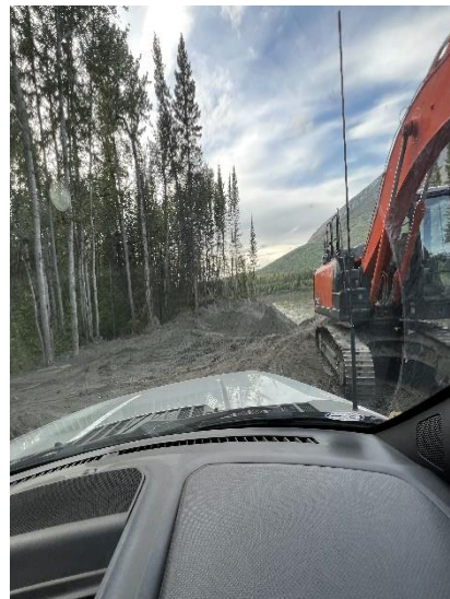
Travaux de construction de la phase III de la rampe de mise à l'eau de Nahanni Butte réalisés à l'aide d'une excavatrice, après l'achèvement de la phase II.
