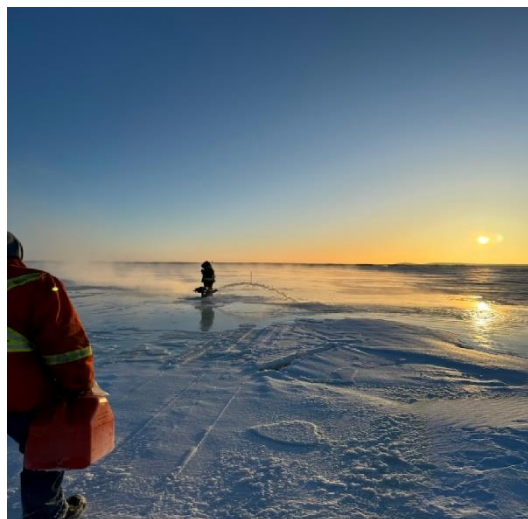
Utilisation de pompes à eau pour former de la glace sur la route de glace de raccordement de Behchokò pendant sa construction (hiver 2023-2024).
