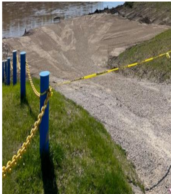
Vue de la rampe de mise à l'eau du parc Bob McMeekin après l'achèvement des travaux d'amélioration, à Hay River.
