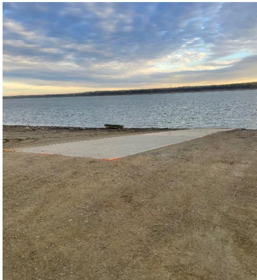
Vue de la nouvelle rampe de mise à l'eau en ciment de 45 pieds, à Fort Simpson.
