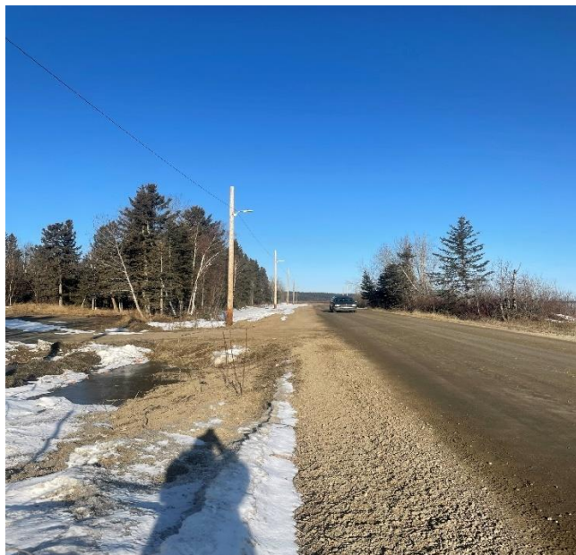
Vue des nouveaux poteaux de 45 pieds équipés de lampadaires de 48 watts le long de la route d'accès à la rampe de mise à l'eau, à Fort Simpson.
