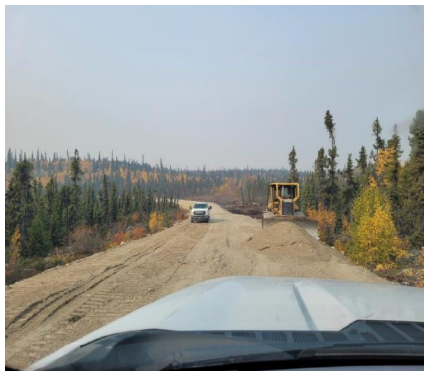
Un bulldozer répand des matériaux granulaires pendant les travaux de construction de la route d'accès à Wekweèti, à l'été 2023.
